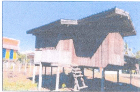
ภาพถ่ายด้านหลังอาคาร
