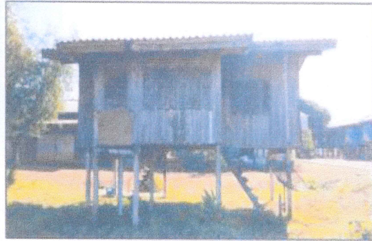
ภาพถ่ายด้านหลังอาคาร
