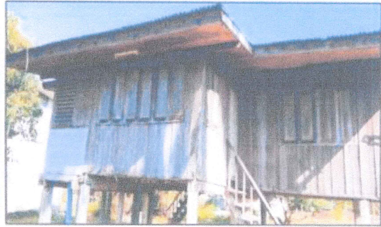
ภาพถ่ายด้านหลังอาคาร
